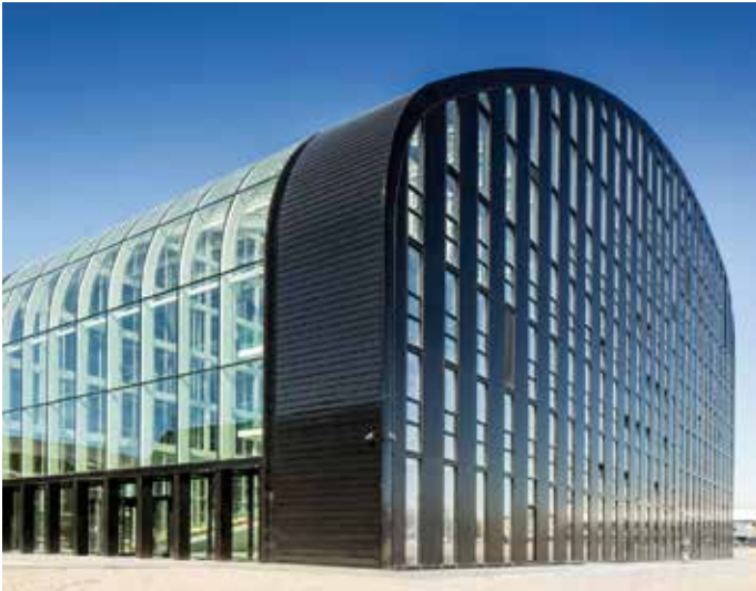
Kantoorgebouw Brussels Instituut voor Milieubeheer, Brussel (B).
