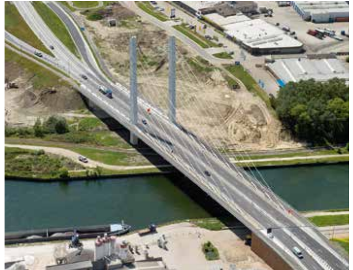
Brug Kempische Noord-Zuidverbinding over het Albertkanaal, Westerlo (B).
