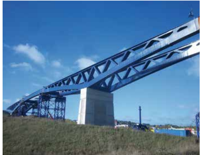
Vakwerkbrug, Junglinster (L).
